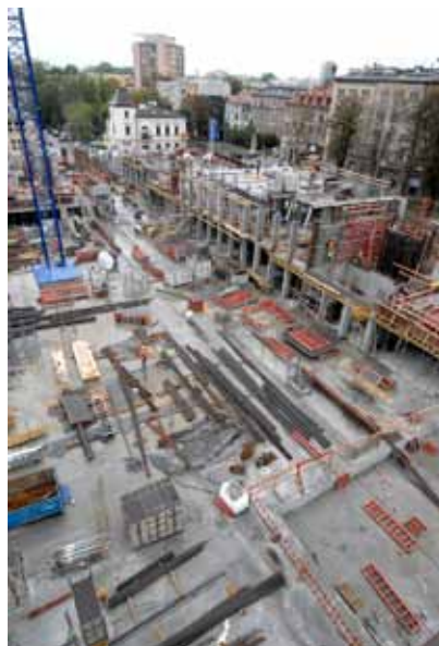
Budowa Centrum Energetyki
