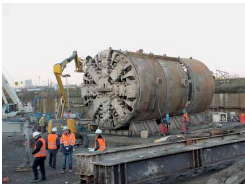
Jedna z tarcz wiertniczych wykorzystywanych przy budowie II linii metra w Warszawie
