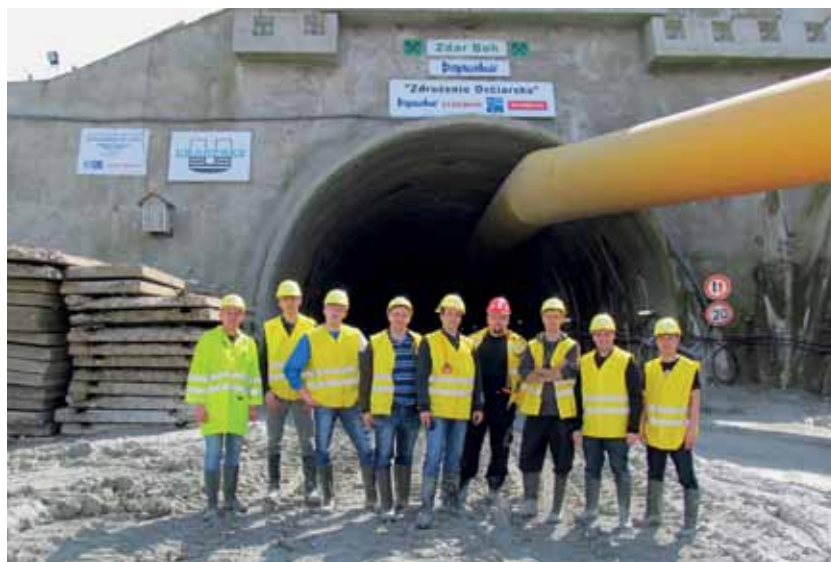
Widok na wlot do dwóch rur tunelu
