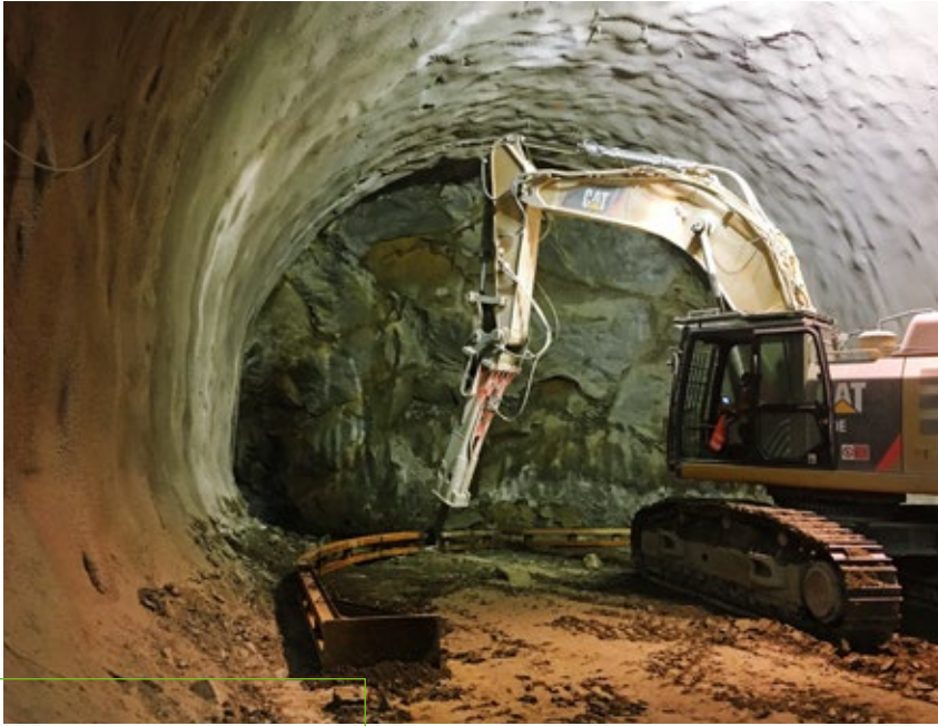
Przykładowe czoło przodka drążonego tunelu
