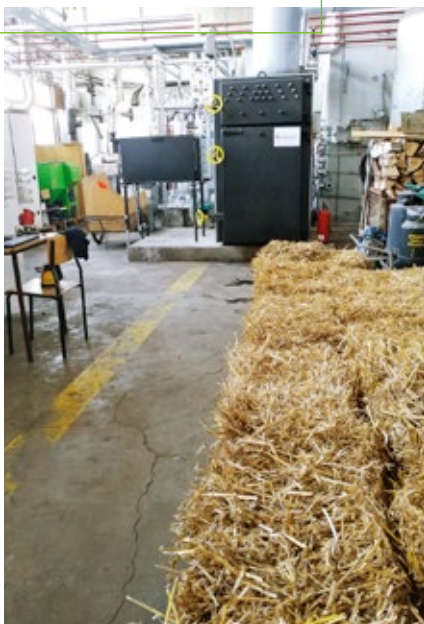
Prace badawcze na instalacji kotła na biomasę – stome
