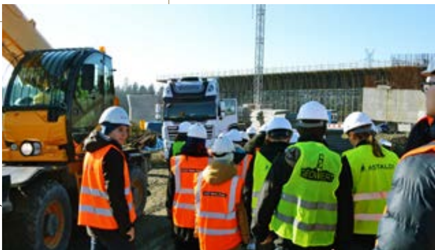
Wizyta studentów na placu budowy tunelu na trasie drogi ekspresowej S-7
