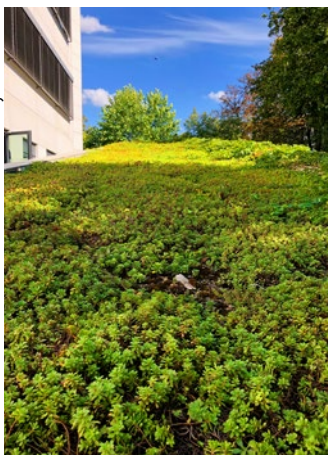
Roślinność ekstensywna na dachu przy bud. D-17
